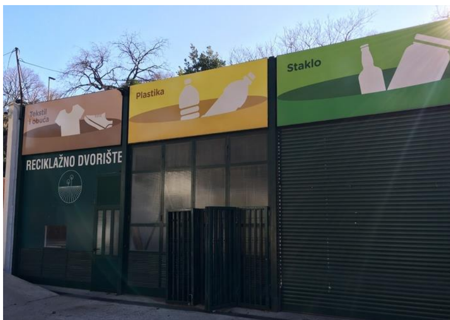
Slika 1. Izgled spremnika u reciklažnom dvorištu
