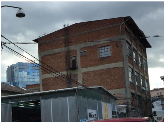
Slika 10: fotografija prikazuje kontrast između oronule zgrade bivše tvornice Katran (unutar koje djeluje klub) i imponantnim PBZ centrom s druge strane Radničke ceste (fotografirala autorica)
