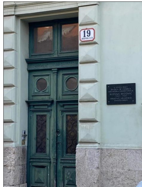
Slika 9. Ulazna vrata kuće
